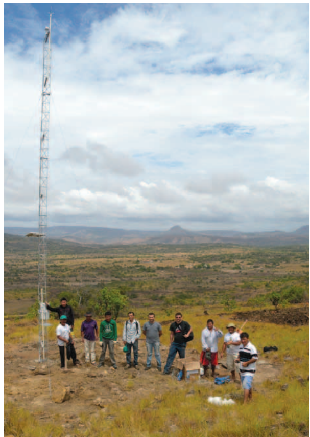
Equipes do CIR, ISA e UFMA durante a instalação da torre de medição na comunidade Pedra Branca
