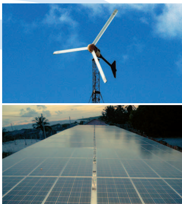
Gerador eólico e painel solar de 150 m 2
