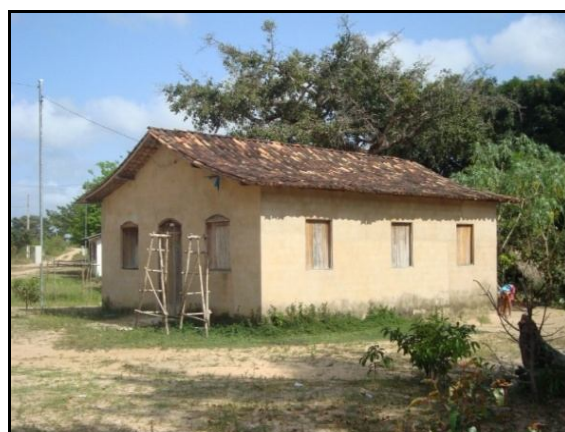
Figura 26: Casa de alvenaria, comunidade Espírito Santo. Fonte: SEMA (2010).
