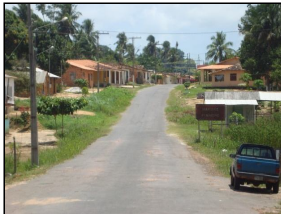
Figura 23: Martins Pinheiro, trecho asfaltado da PA-430. Fonte: SEMA (2010).
