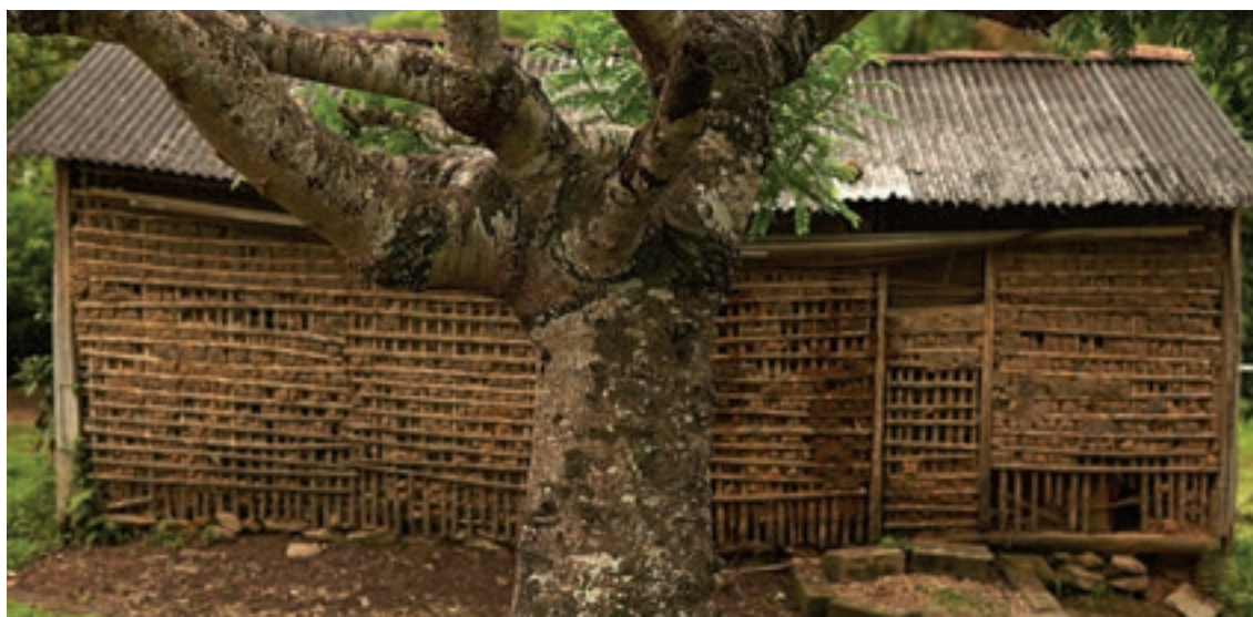
Foto: Casa de pau a pique, Quilombo de Ibaporunduva, Eldorado (SP). ©Loiro Cunha/ISA
