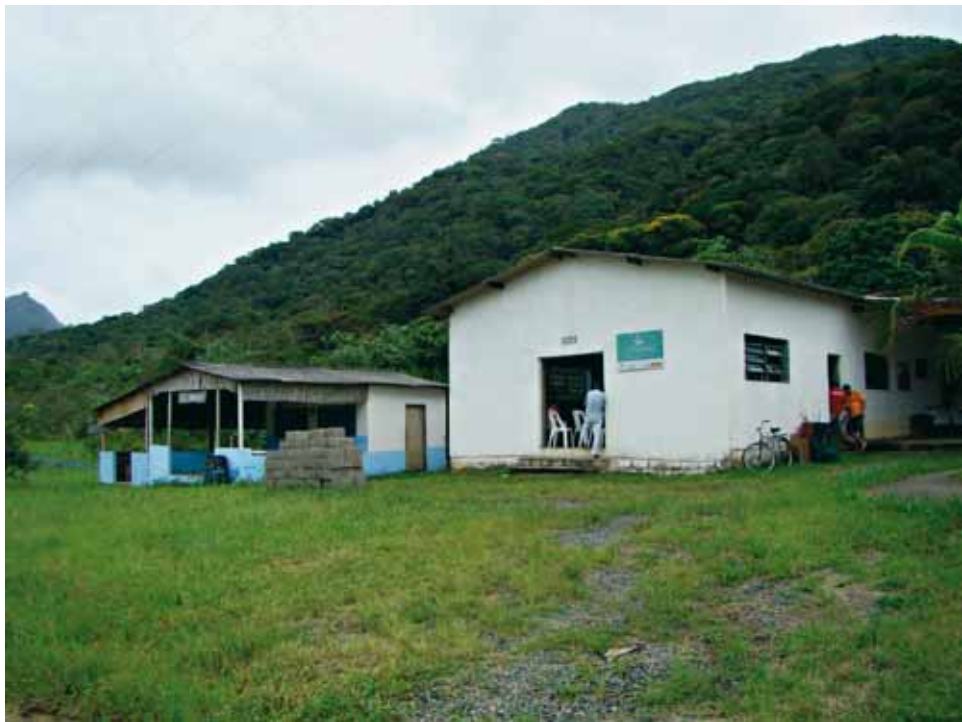
Centro comunitário onde funciona o Telecentro.
